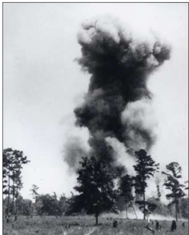
Der erste Refraktionsschuß in den USA fiel am 24.7.1923 in Oklahoma.
